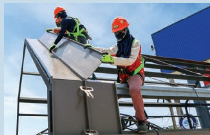
5. ติดตั้งแผ่นแซนวิชแผ่นสอง และติดจากรูป CozyClip ชุดสาม
