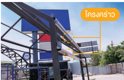
1. ติดตั้งโครงคร่าวรับผนัง
