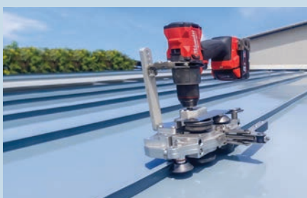
6.2 ซึมลอนประกอบของแผ่นแซนวิชด้วย Electric Seamer
