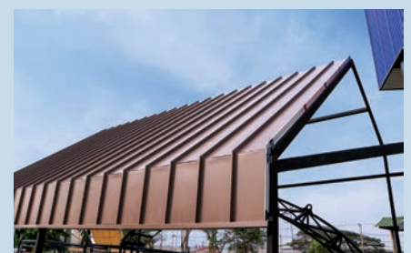
7. ทำการติดแผ่นแซนวิชและจากรูปชุดถัดไปจนเต็มพื้นหลังคา
