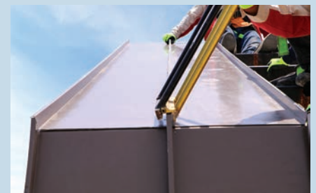
6.1 ซึมลอนประกอบของแผ่นแซนวิชด้วย HandSeam
