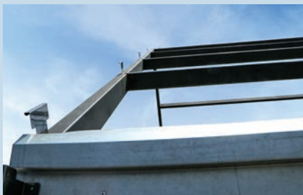
1. ติดตั้งจากรูป CozyClip ชุดแรก ในทุกแป โดยยึดด้วยสกรู
