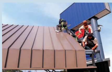
7. ทำการติดแผ่นแซนวิชและจากรูปชุดถัดไปจนเต็มพื้นหลังคา
