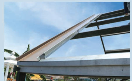
3. ติดตั้งจากรูป CozyClip ชุดสอง ในทุกแป
