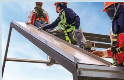
2. ติดตั้งแผ่นแซนวิชแผ่นแรก กับจากรูป CozyClip
