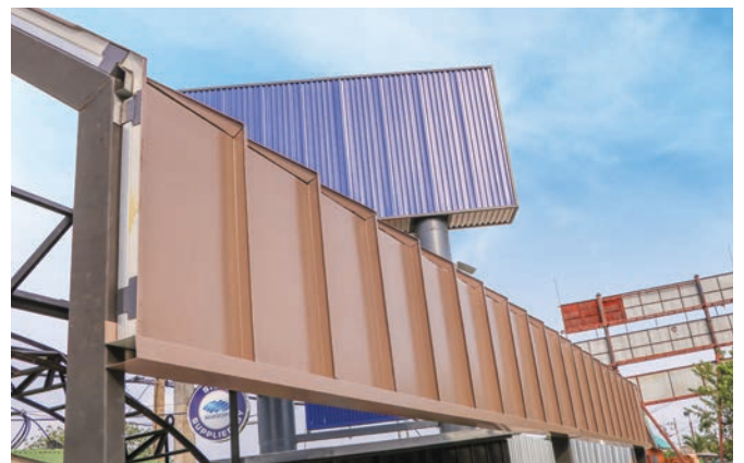
5. ภาพหลังจากติดตั้งแผ่นผนังเสร็จแล้ว
